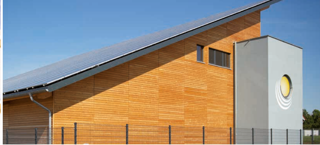
Holzbau Kühlborn GmbH, 34286 Spangenberg, Germany
